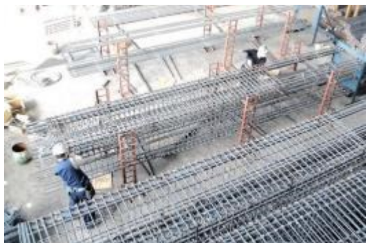
梁鉄筋工場地組
