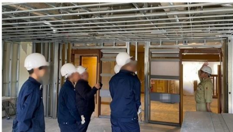
天井部での電気設備の施工について説明 (配線等は、後の内装工程で隠される事例が多いです)
